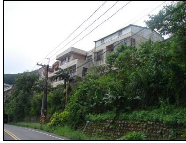
(b) 災前現勘位置點 4，不適當擋土牆型式與排水條件不良處
