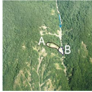
(b) 岩屑崩滑，A 為長條型裸露區，B 為崩塌堆積區。
