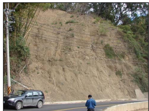
圖2 陡坡崩落顧名思義是發生在較陡邊坡，亦有發生在45度左右邊坡，表層材料風化成岩屑或土，由於風化層厚度不會太厚，在含水量增加狀況下，材料會以墜落或滾動方式向下坡運動，並在坡腳形成崖錐堆積。與落石類山崩災害相同，多以混凝土噴漿、型框植生或是掛網植生等方式穩定坡面。
