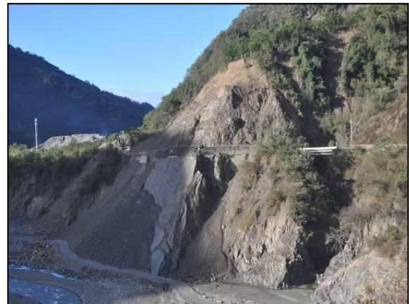
圖6 平面型滑動多發生在順向坡因坡趾出露，完整的塊體因而向下坡運動。多發生在砂頁岩互層，當坡趾出露，加上雨水或地下水入滲，使得頁岩軟化，上方砂岩塊體即沿著下方頁岩面運動。照片中係因河流掏刷坡腳，造成坡趾出露。
