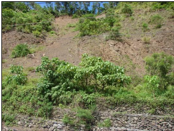
圖3 弧形崩塌多發生在較厚風化層之緩坡，材料為岩屑或土壤，與陡坡崩塌最大差別在於有明顯滑動面及弧形冠部，滑動後的塊體多能維持其完整性，不似陡坡崩塌材料在運動後之分崩離析。多以擋土設施與排水設施進行整治，照片中係以箱籠阻擋塊體滑動。
