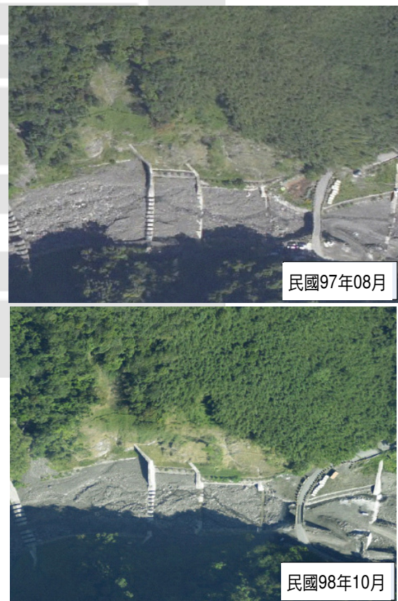
圖 14 蘇樂溪集水區植生復育狀況航照比較圖
