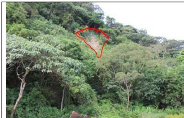
③災害點 41, 45 位置，為研究區北側高地公園入口，根據台北市 1/1,000 地質災害敏感區分布圖顯示編號 41 為淺層崩塌區，編號 45 為落石崩塌區，經現場勘查發現編號 41 淺層崩塌區已近乎完整復育，編號 45 區落石崩塌區上殘留崩塌土與崩崖痕跡，坡面已設置有抗沖蝕網，減少降雨坡面沖蝕土體流失現象，邊坡坡度大於 55 度，且樹木有部分向下邊坡傾斜，保全對象僅下邊坡道路。(307316,2766433)
