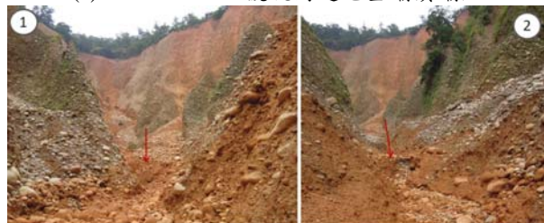
(b) 2012/08/02 一號坑河道堰塞壩潰壩點
