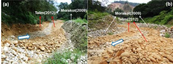
圖 12 土石流波峰流經後之側堤地貌(06/21)
