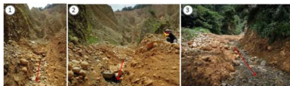
(a) 2012/06/21 一號坑河道堰塞壩潰壩點
