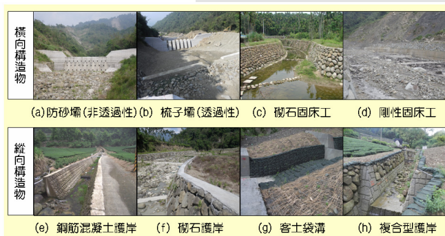
圖 4 河道防砂構造物種類示意圖
